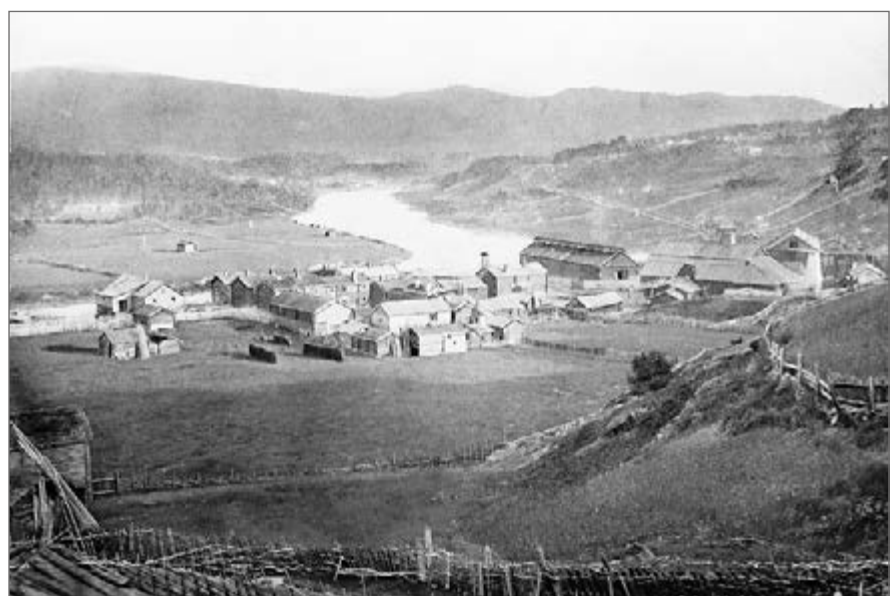
Tolgen hyttiplass ca 1870. I midten på bildet kan en se «Hyttstua»(administrasjonsbygget) med klokketårn. Videre ser en venderøsthytta. Et stykke bak denne foregikk kaldrøstinga av malmen. Der heter det fortsatt «Røstvedhagen». Den største bygningen er selve smeltehytta. I den øvre enden av den kan en se den lyse pipa til garovnen. Bak denne igjen ser en toppen av kolhuset med ei lang, høy kjørebru inn mot monet. Foto: Elen Schomragh
