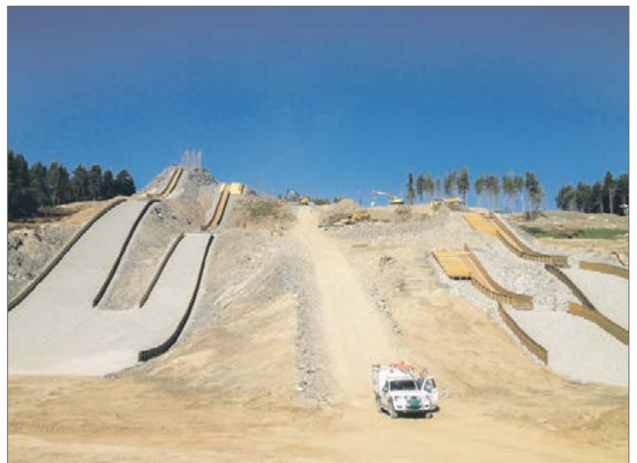
Skilekanlegget i Hamran er snart ferdig. Foto: Thorbjørn Liell / Ingrafo
